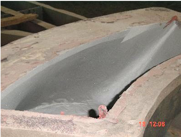
上圖：進入管道連結接頭，經噴砂處理後。
