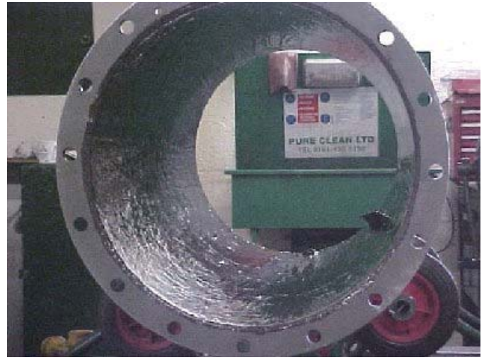
使用金屬防護塗層平面塗佈外殼內部
