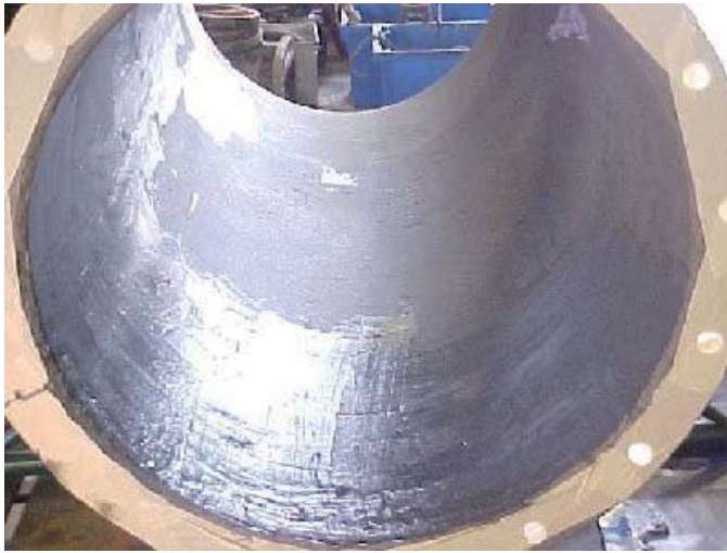
使用金屬再生劑填平內部坑洞後
