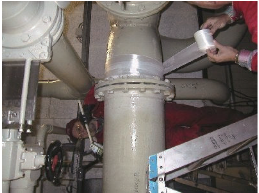
真正不動明火，安全使用強化玻璃纖維布包覆的情況
